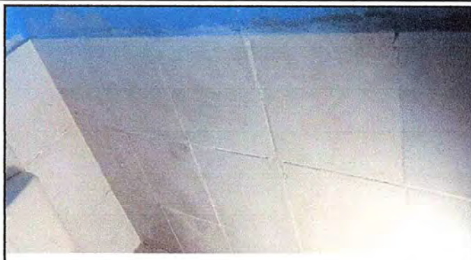
Foto 2: nuevo piso ya instalada.
