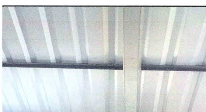
Foto 6: entechadas de aulas remozadas.
