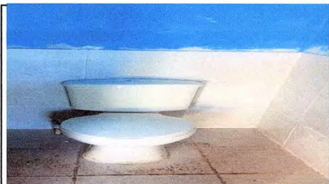
Foto 3: nuevos inodoros ya instalados.
